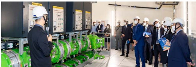
Visita à subestação do Pac On, parte da nova interligação
